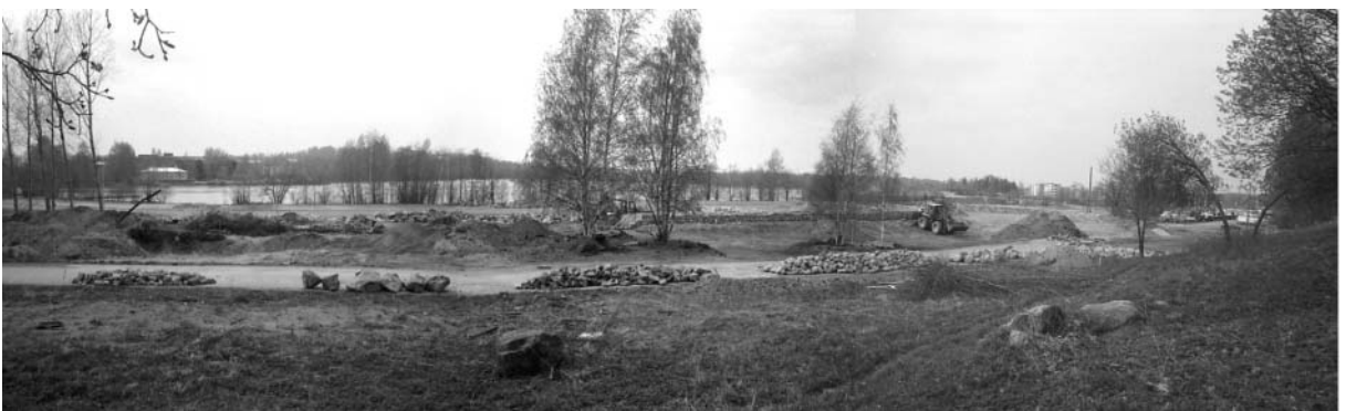
MV:RHOA 125373: 44-46. Yleiskuva linnoituksen länsirinteen alueesta, jolla on sijainnut kaupunkia edeltänyt markkinapaikka ja markkinakylä. Taustalla on käynnissä linnoituksen länsirannan puolustuslaitteiden restaurointityöt. Kohti W-NW.
