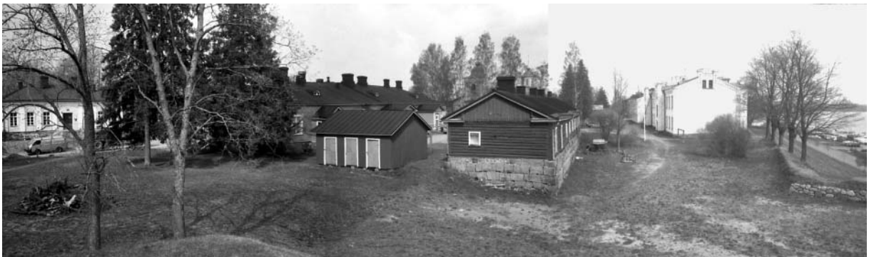
MV:RHOA 125373: 33-35. Linnoitusalueen eteläpään tontit 1-19-1 (keskellä) ja 1-19-2 (oikealla) kuvattuna Viipurin portin vallitukselta Upseeripuiston yli. Kohti NW-N.
