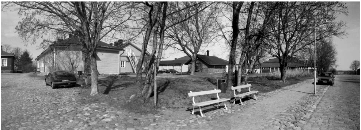
MV:RHOA 125373: 17-19. Kristiinankadun länsireunaa Friisenheiminkujan ja Katariinantorin välillä. Kuvassa etualla oleva on jätetty vuoden 1997 kaavamuutoksen ulkopuolelle eikä sillä ole rekisterinumeroa. Oikealla Kristiinankatu. Kohti W-N.
